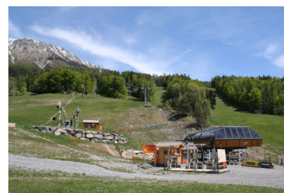
Enrochements, forte pente peu végétalisée, installations mécaniques, brèche des pistes dans le manteau forestier (Montclar)
