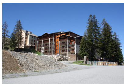
Entrée de station marquée par une voirie surdimensionnée, des terrassements et enrochements bruts et des conteneurs (Chabanon - Selonnet)
