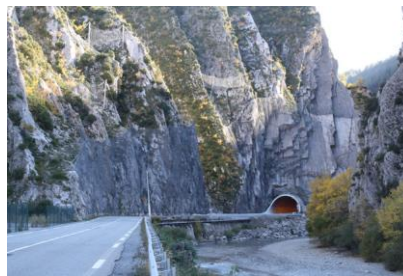
RN 85 - Tunnel et mise en sécurité du versant de la clue de Chabrières
