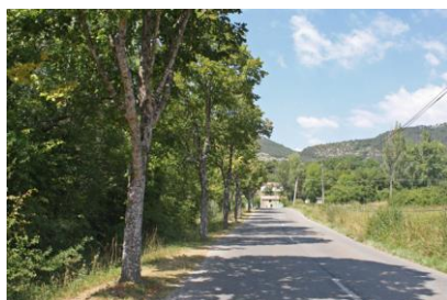
RD 952 fossés et accotements enherbés (La Palud-sur-Verdon)
