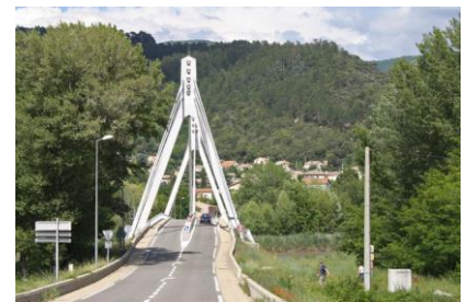
RD 404 - Pont sur la Durance (Volonne)
