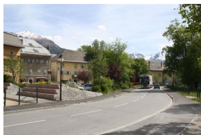
Aménagement de sinuosité, trottoirs et plantations dans la traversée de Jausiers (RD 900)
