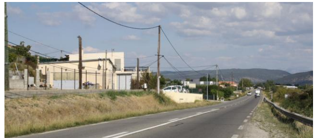
Continuité d'urbanisation diffuse, réseaux aériens et accotements purement routiers, en val de Durance, en bord de RD 4996 (Villeneuve)
