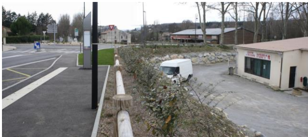
Giratoire desservant des bâtiments d'activités, de commerces ou équipements lâches, entourés de larges parkings avec enrochements et sans plantations (Céreste)
