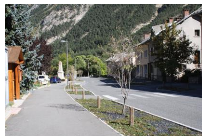
Plantations séparant la chaussée du trottoir dans la traversée de La Condamine-Châtelard (RD 900)
