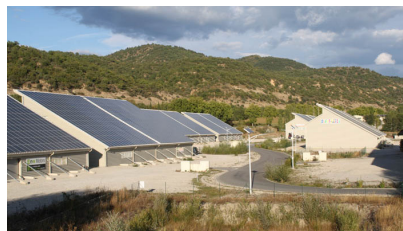
Bâti d'activité conçu pour des toitures photovoltaïques maximales (Malijai)
