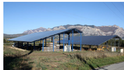
Hangar photovoltaïque en milieu agricole (Claret)
