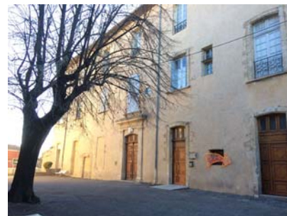
Château remanié au 18 ème siècle dans le tissu urbain ancien
