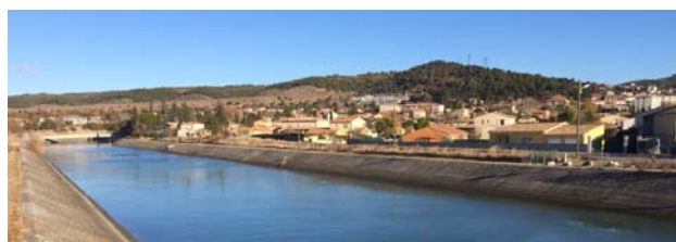
Extensions sous forme de lotissements jusqu'au canal EDF
